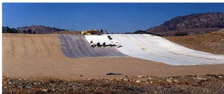
Слика – постављање доње непропусне фолије
